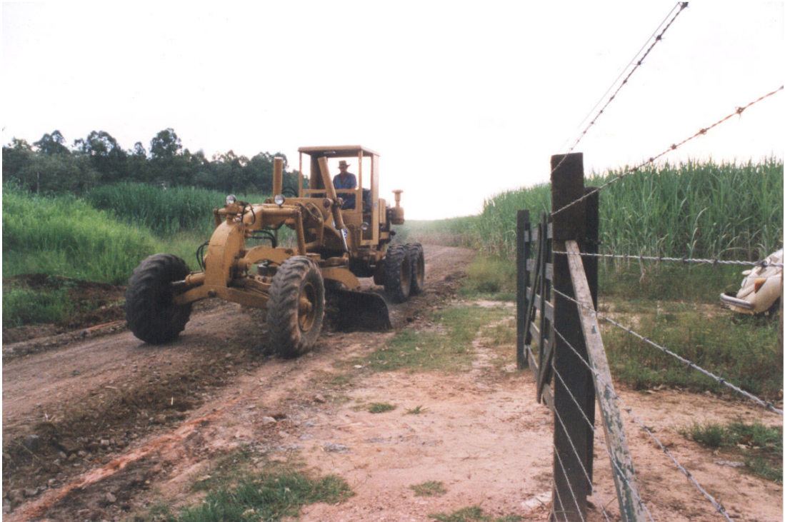
Trabalho iniciado em 1997 visando à recuperação e alargamento das principais estradas rurais do município, com cascalhamento feito com rejeito de calcário.
