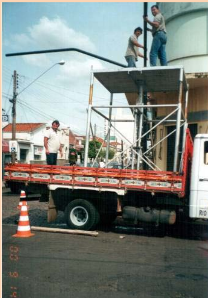
Figura 14. Equipe de Rio claro em plena atividade com o equipamento copiado.
