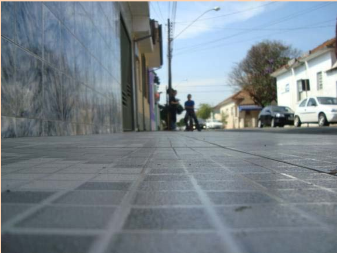
Figura09. Calçada de piso cerâmico. Um perigo em dias chuvosos. Avenida 13 Rio Claro.
