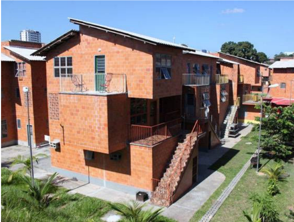
Figura 2. PROSAMIM - edificações de três andares, que utilizam telhas de amianto, com janelas pequenas que não permitem a circulação adequada do ar, março de 2010.
