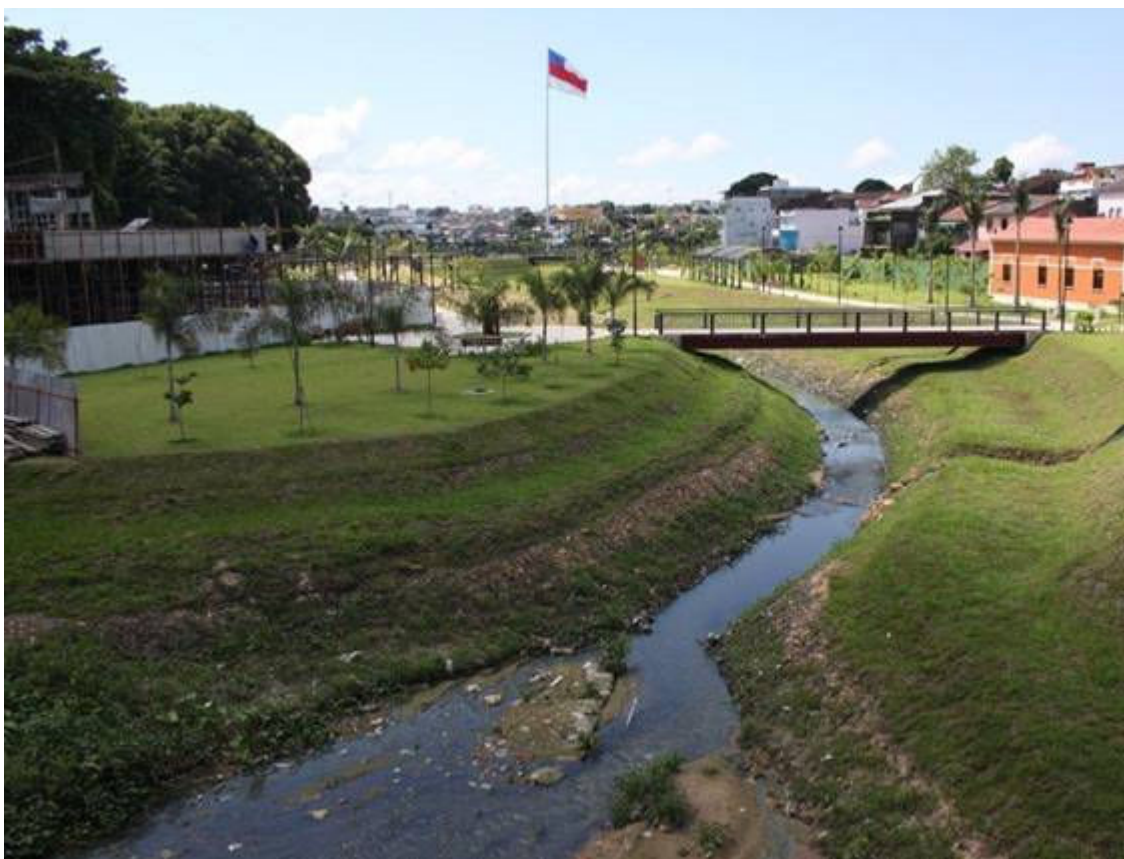
Figura 5. PROSAMIM – observa-se a presença de lixo no leito do corpo d'água a jusante dos prédios construídos para moradia, o que pode agravar o alagamento no período de cheia natural do rio Negro, em março de 2010.
