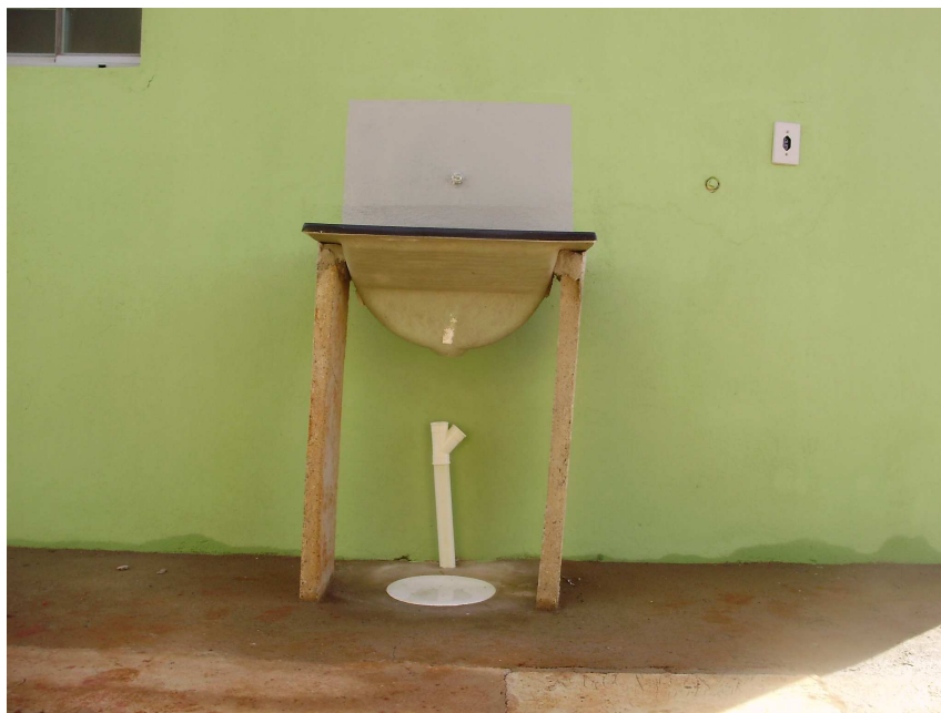
Foto 10: Tanque mal construído. Autor: AZEVEDO, 2010.
