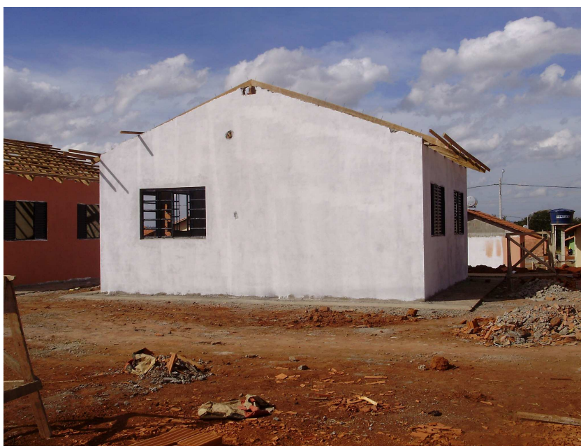
Foto 14: Construção em estágio final. Autor: AZEVEDO, 2010.
