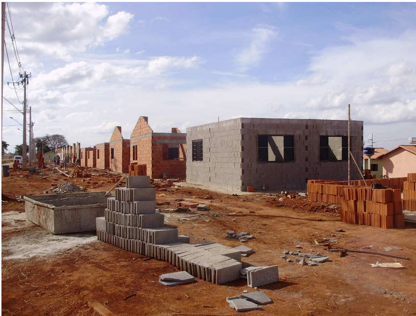
Foto 12: Casa sendo levantada. Autor: AZEVEDO, 2010.
