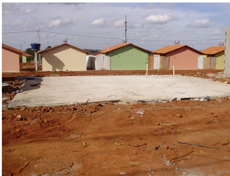
Foto 06: “Radie” em construção. Autor: AZEVEDO, 2010.
