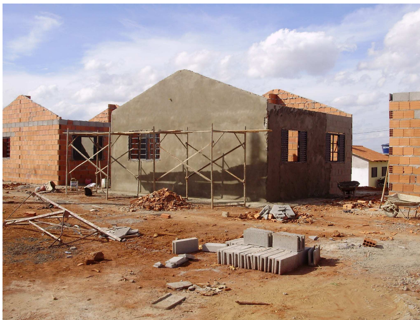
Foto 13: Construção em estágio avançado. Autor: AZEVEDO, 2010.
