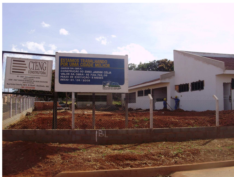
Foto 15: EMEI Jardim Célia em fase de construção. Autor: AZEVEDO, 2010.
