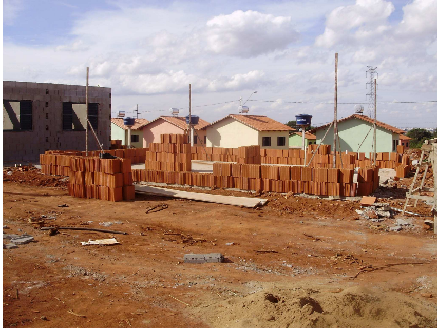
Foto 11: Início da construção das unidades habitacionais. Autor: AZEVEDO, 2010.
