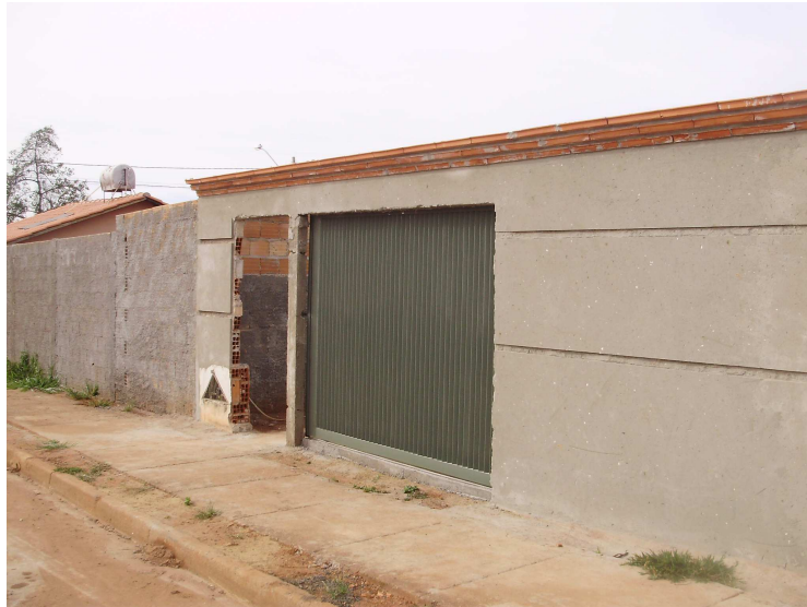
Foto 03: Muro em construção. Autor: AZEVEDO, 2010.
