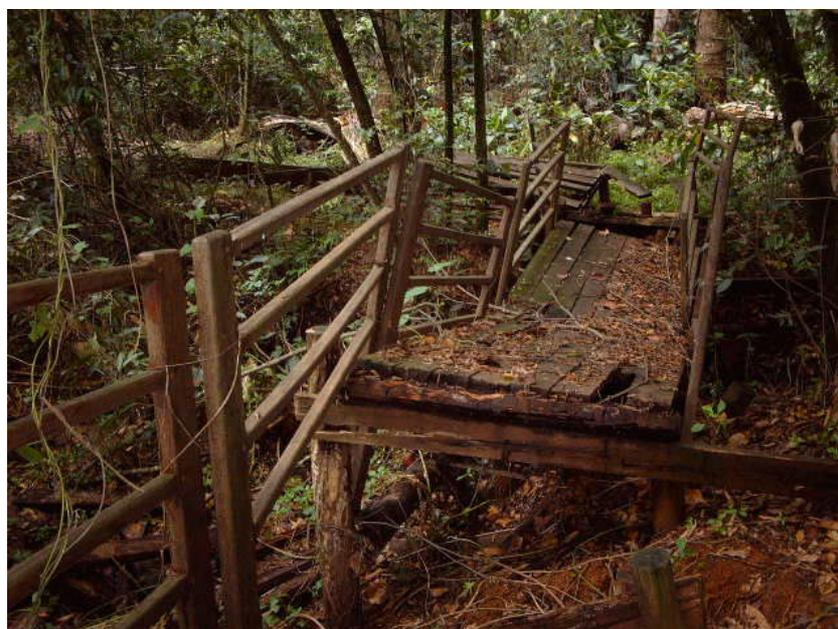
FOTO 14: Parte da trilha de madeira, desgastada com o tempo e sem manutenção.
